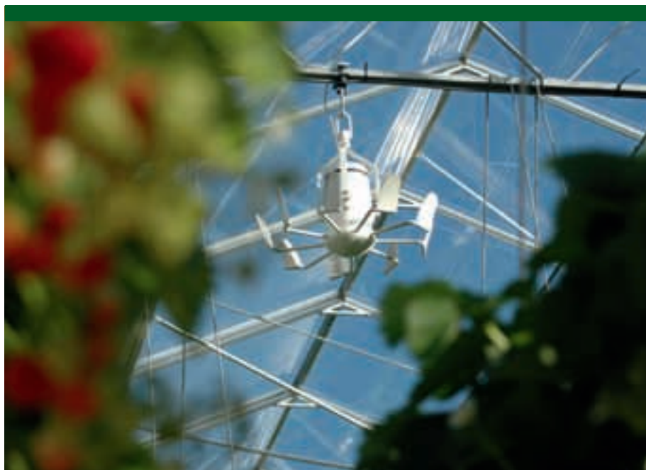
Op basis van verschillende koelsystemen op zijn bestaande bedrijf, koos Dings in zijn nieuwe kas voor een vernevelingsinstallatie en een aircobreeze.
